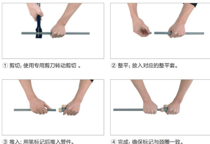
图 1. PE-RT II型管推入式连接
