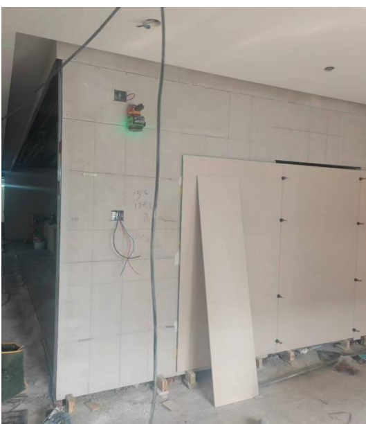
图4. 泰山GF板墙面基层衬板图
