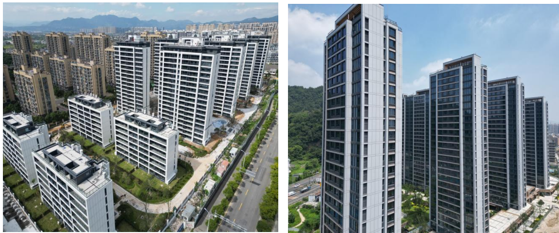
图1. 外墙铝板实景图
